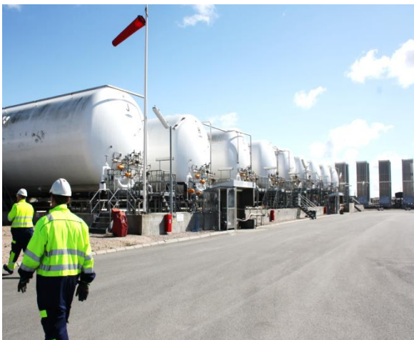
LNG reloading and bunkering station project
